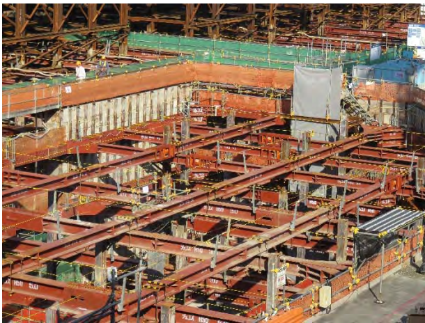
地盤改良工事のための地上鋼材建造物
