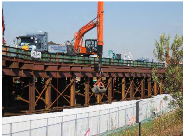
地盤改良工事の現在の土壌の撤去作業
