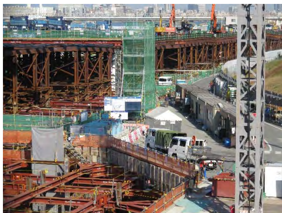
地盤改良工事のための地上鋼材建造物
