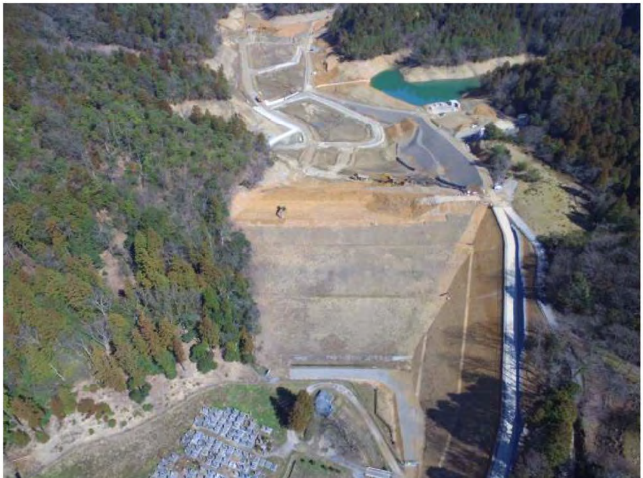
施行中の様子 (R2.3.7時点)
