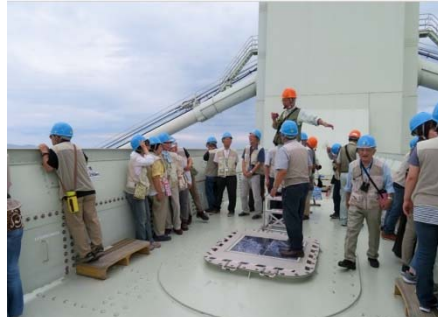
明石海峡大橋
