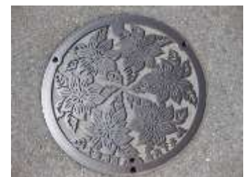
下水マンホール
