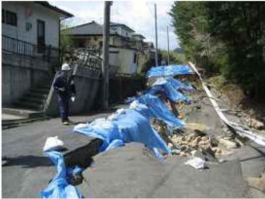
東日本大震災による宅地被災（山元町太陽団地）
